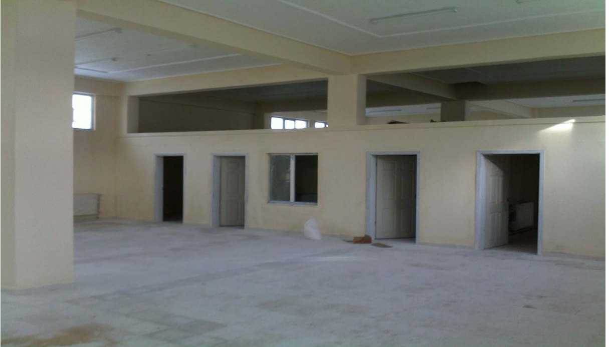
Akdağmadeni Meslek Yüksekokulu Atölye İnşaatı (İç Görünüş)
