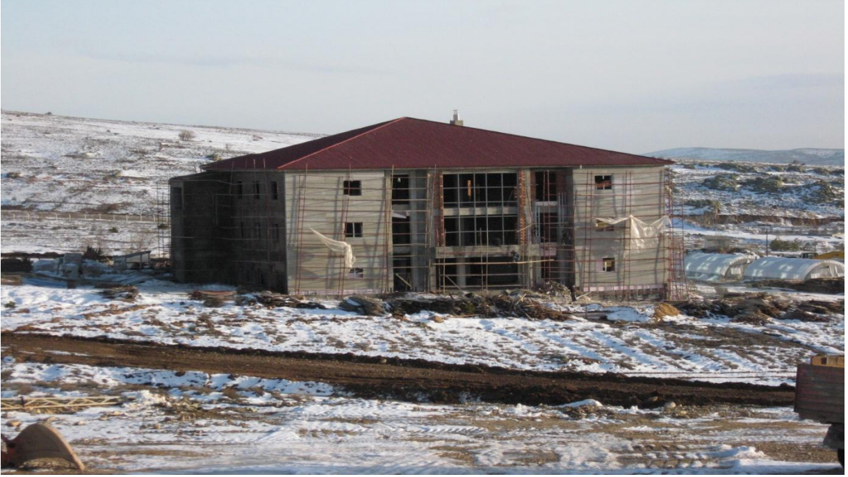
Merkezi Kütüphane ve Bilgi İşlem Merkezi Binası (2008)
