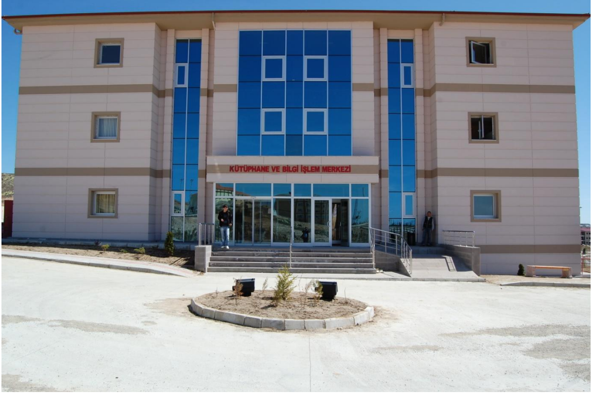
Merkezi Kütüphane ve Bilgi İşlem Merkezi Binası (2009)
