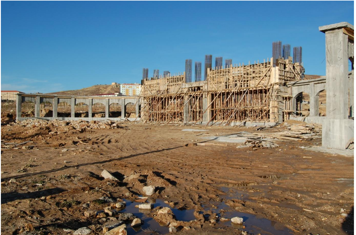
*Bozok Üniversitesi Giriş Kapısı İnşaatı
