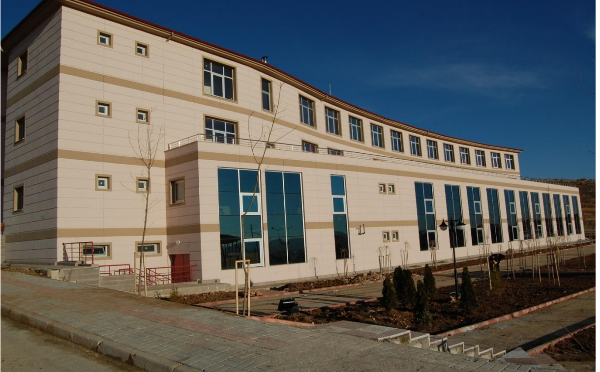
Merkezi Kütüphane ve Bilgi İşlem Merkezi Binası (2009)
