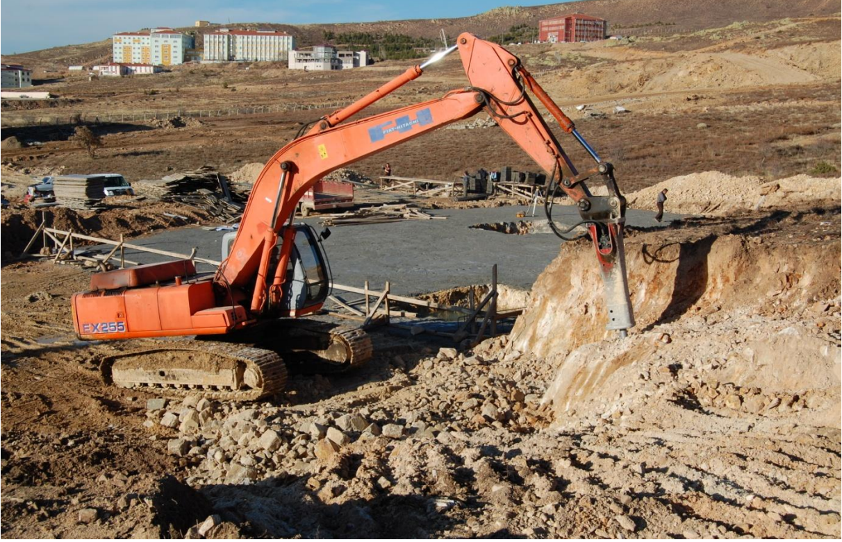
Ziraat Fakültesi Binası Yapım Çalışmaları(2009 yılı)
