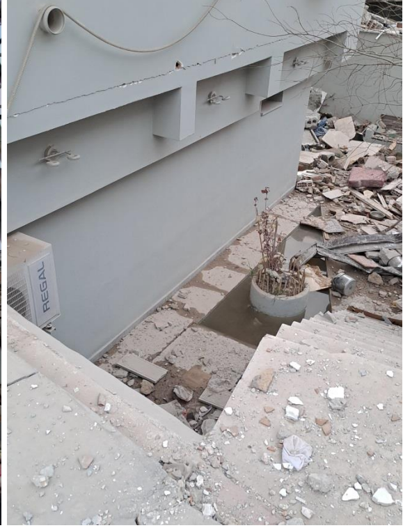
Şekil 19. Antakya'daki bir binanın temelinde sıvılaşmanın neden olduğu su ve kum çıkışı
