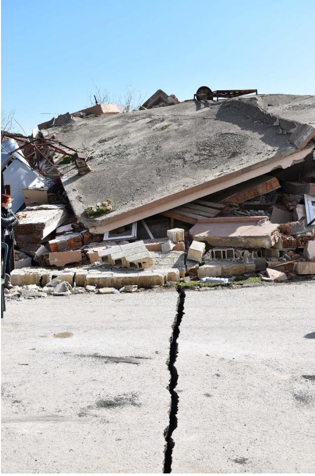
Şekil 37. Deprem yüzey kırığına denk gelen bir yapı
