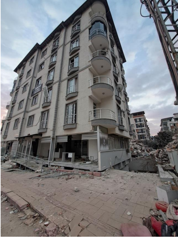
Şekil 19. Antakya'daki bir binanın temelinde sıvılaşmanın neden olduğu su ve kum çıkışı
