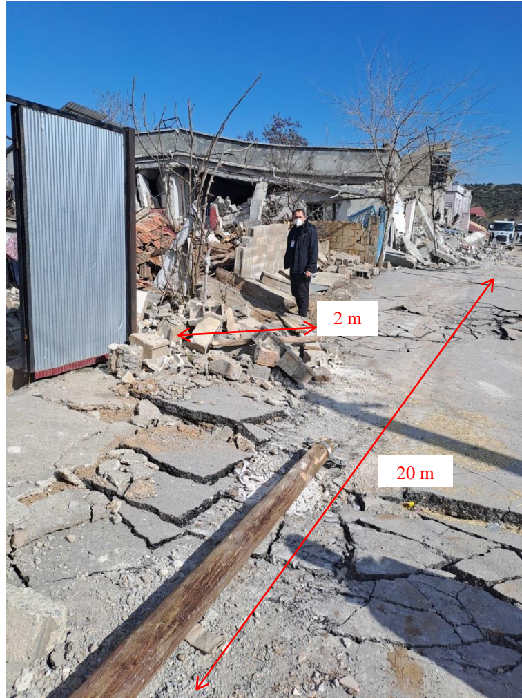
Şekil 11. Şekerobası'nda yaklaşık yüzey kırıklarının izlendiği yaklaşık 20 m genişlikteki fay zonunda zemin ve yapıların deformasyonu
