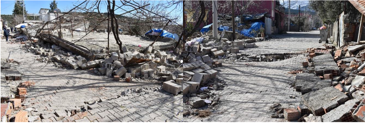
Şekil 38. Düşey atımın gerçekleştiği bir bölgedeki yapı
