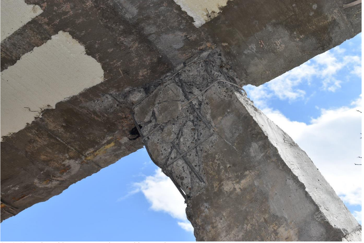
Şekil 39. Etriye sıklaştırması yapılmamış bir yapı elemanı
