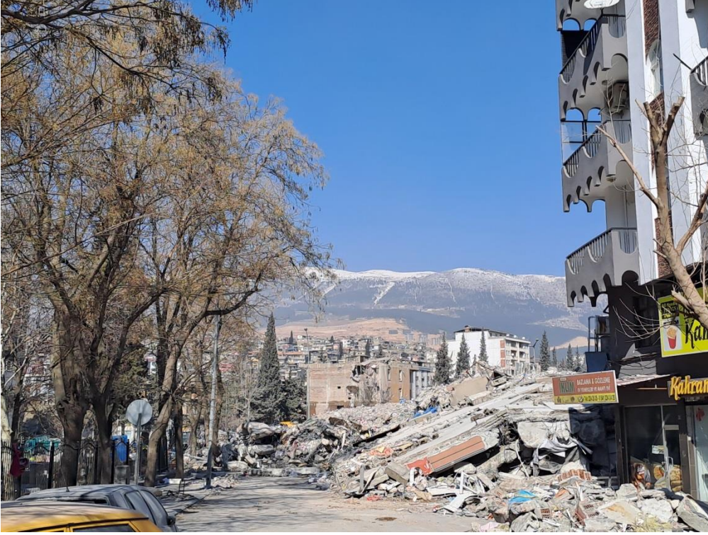
Şekil 24. İnceleme alanındaki çimentolanmamış zeminler (Alüvyon) üzerindeki yapılarda meydana gelen deprem hasarları (Maraş)
