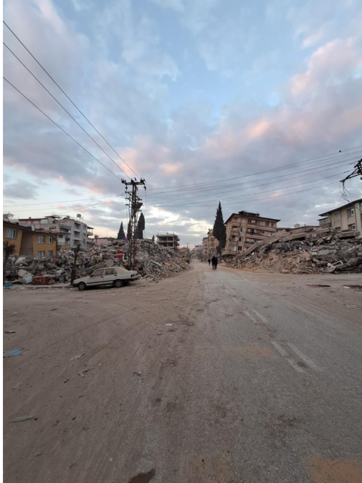
Şekil 23. İnceleme alanındaki çimentolanmamış zeminler (Alüvyon) üzerindeki yapılarda meydana gelen deprem hasarları (Nurdağı)
