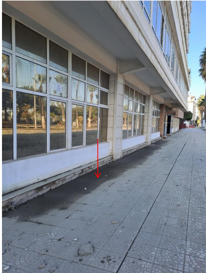
Şekil 22. İskenderun sahildeki bir binanın temelinde gelişen sıvılaşmaya bağlı oturma
