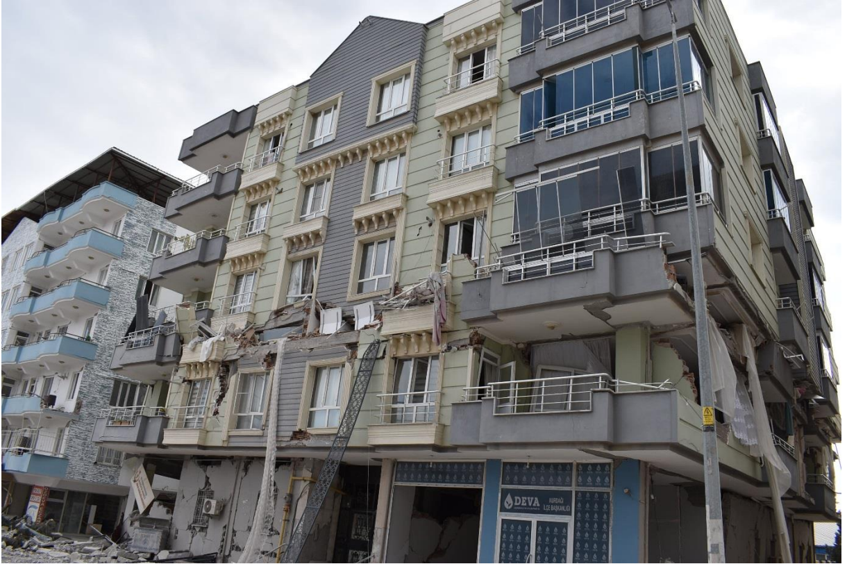
Şekil 44. Ara kat göçmesi
