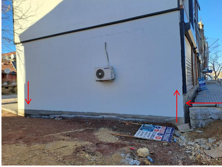
Şekil 16. Gölbaşında zayıf zemin üzerindeki çok katlı binanın temelinde meydana gelen farklı oturma
