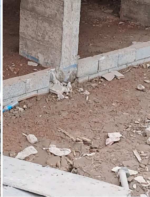
Şekil 20. Antakya'daki yeni bir binanın temelinde sıvılaşmanın neden olduğu su ve kum çıkışı
