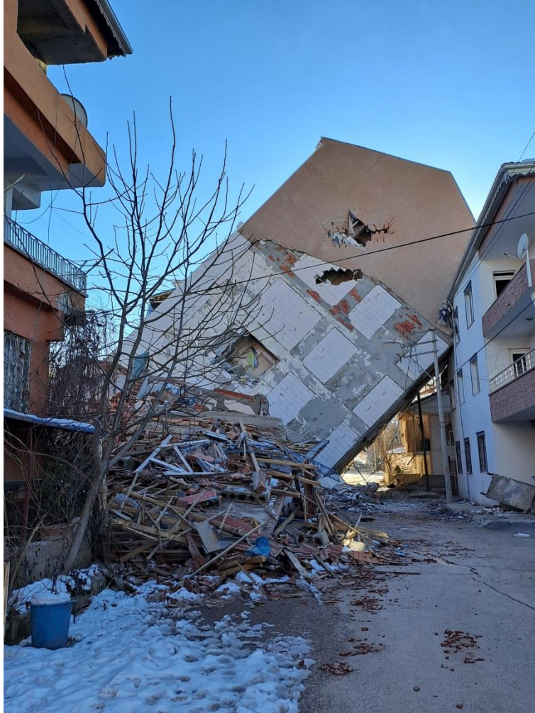
Şekil 17. Gölbaşında zayıf zemin üzerindeki çok katlı binanın temelinde meydana gelen aşırı farklı oturma sonucu yapının devrilmesi
