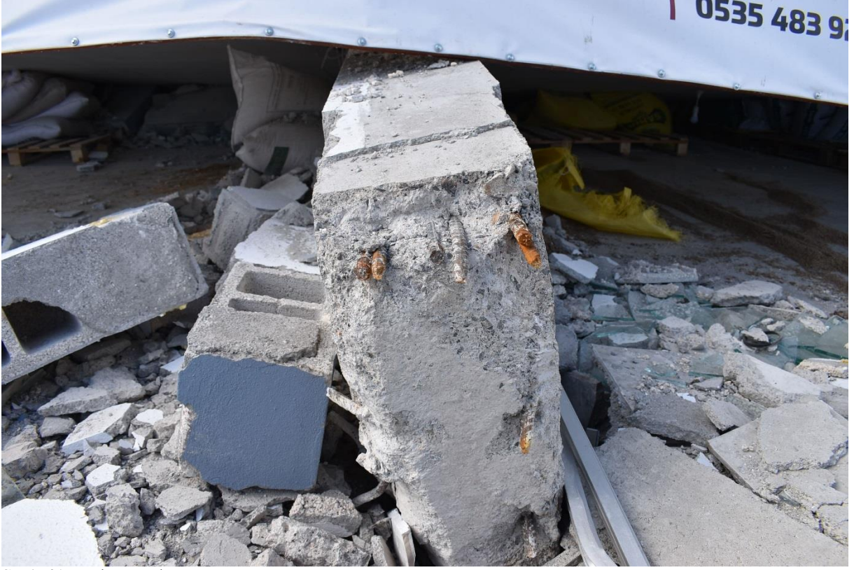
Şekil 41. Paslanmış donatı
