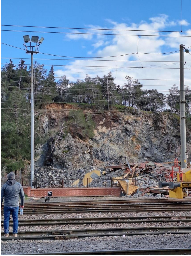
Şekil 13. Fevzipaşa'da tren yoluna doğru gelişen kütle hareketi
