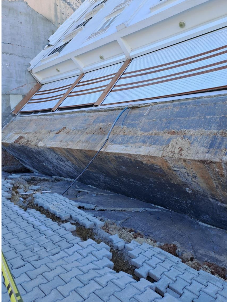
Şekil 18. Devrilen binanın yaklaşık 80 cm kalınlığındaki radye temeli
