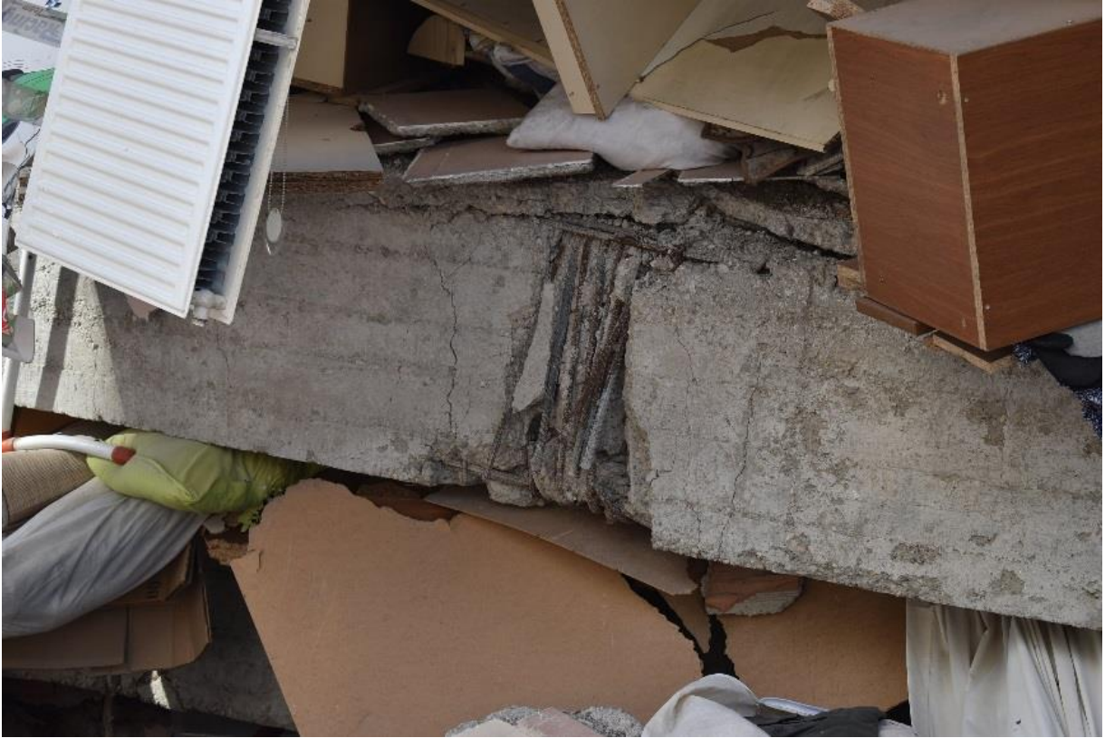
Şekil 42. İmalat aşamasında işçilik hatası kaynaklı bağlanmamış donatıların kümelenmesi
