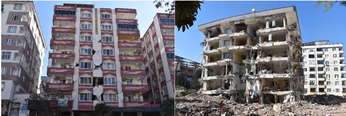
Şekil 36. Taşıyıcı sistemi ayakta kalan fakat duvarları hasarlı binalar
