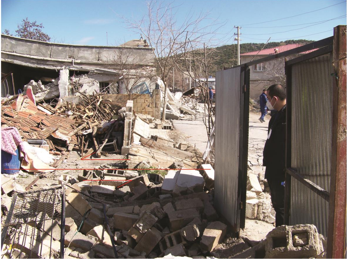
Şekil 9. Şekeroba Köyünden geçen deprem yüzey kırığı sol yanal atım yaklaşık 2 m olarak ölçülmüştür, Lokasyon (37.25427 K, 36.77445 D) m
