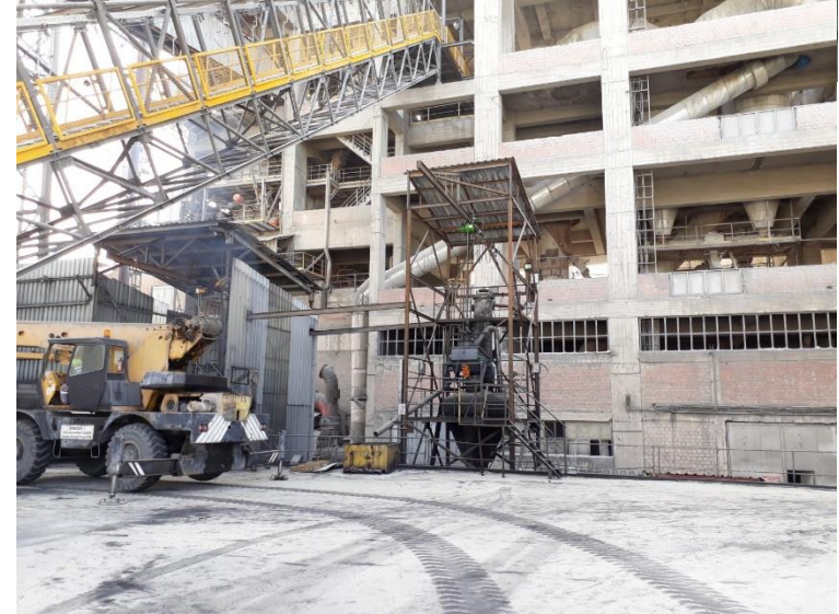
Yozgat Votorantim Çimento Fabrika İşletmesi
